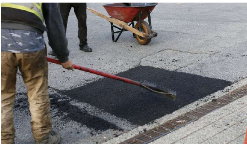
Figura 5. Comparativa de reparación de baches.
