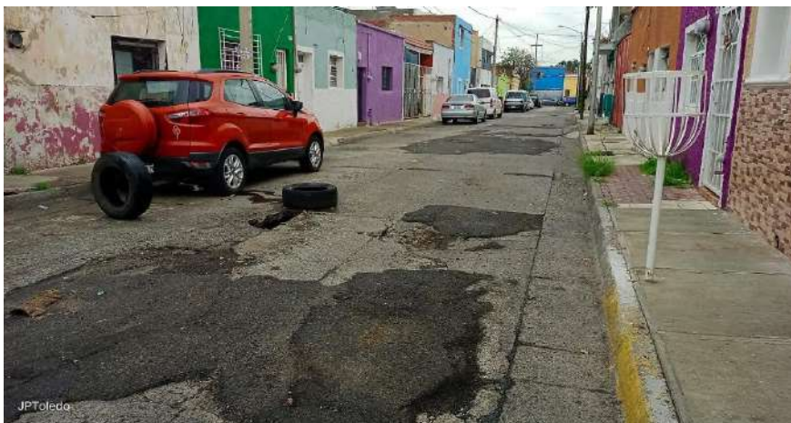
Figura 4. Comparativa de reparación de baches.
