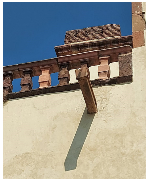
Fig.140 Muro de adobe en esquina del templo para avisar sobre la llegada de los federales en época de cristeros. Fuente: fotografía de autora, noviembre 2022.
