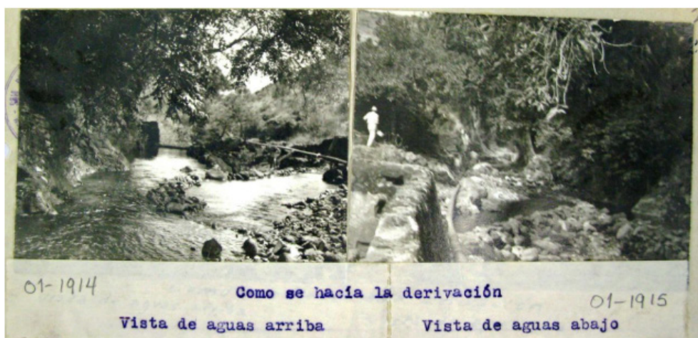
Fig. 41 Fotografías históricas de la construcción de represas para distribuir el agua del río Taretan. Fuente: fotografía de Hernández 2011, p.24.
