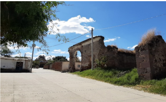
Fig. 36 Ruinas de la casa de la exhacienda de La Ciénega del Pastor. En la imagen se observan los grandes muros de piedras y fragmentos de cerámica con la que fue construida, así como parte de la entrada principal. Fuente: fotografía de autora, noviembre 2020.
