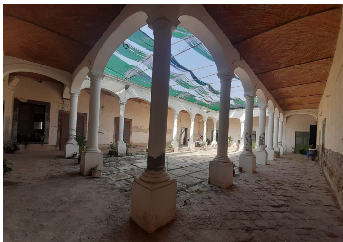
Fig. 75 Interior de la vivienda de la casa de la hacienda de Margaritas. Fuente: fotografía de autora, noviembre 2020.
