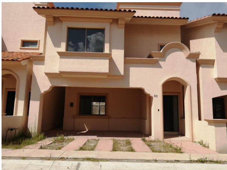
Figura 21 Prototipo de vivienda en el fraccionamiento Villa California
