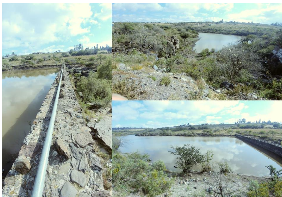
Cortina de la presa San Miguelito
